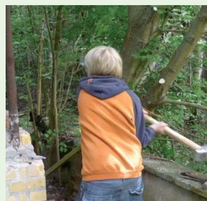
Abriß der alten „Grillhütte“
